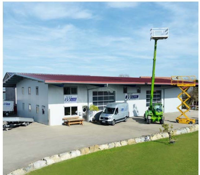
Lagerhalle für Ersatzteile und Maschinen
